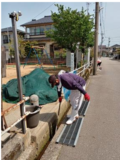
荒屋児童公園横の側溝清掃
