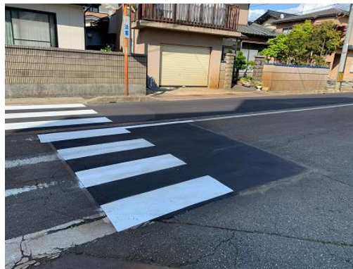
道路補修（舗装）（1班エリア）
