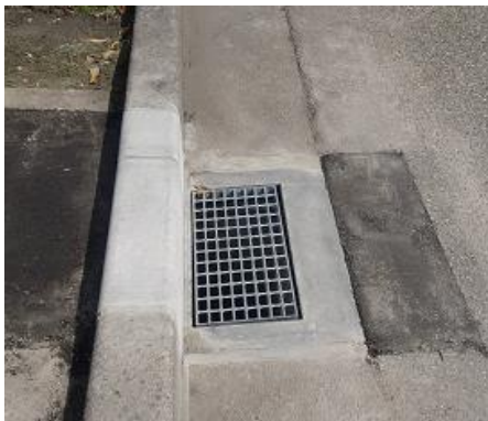
排水溝を設置（荒屋八幡公園近く）
