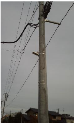
新設された街灯
