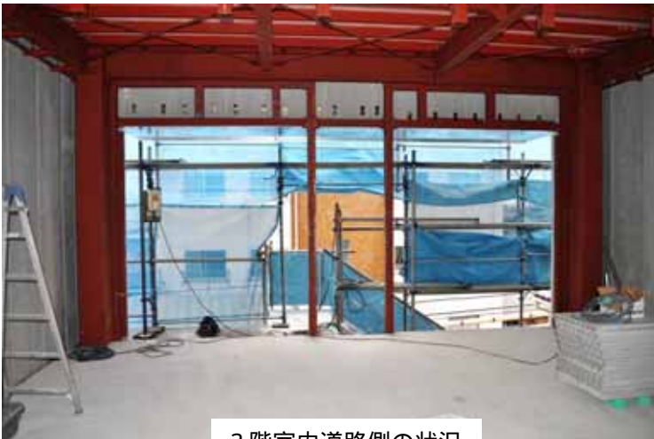
3階室内道路側の状況
